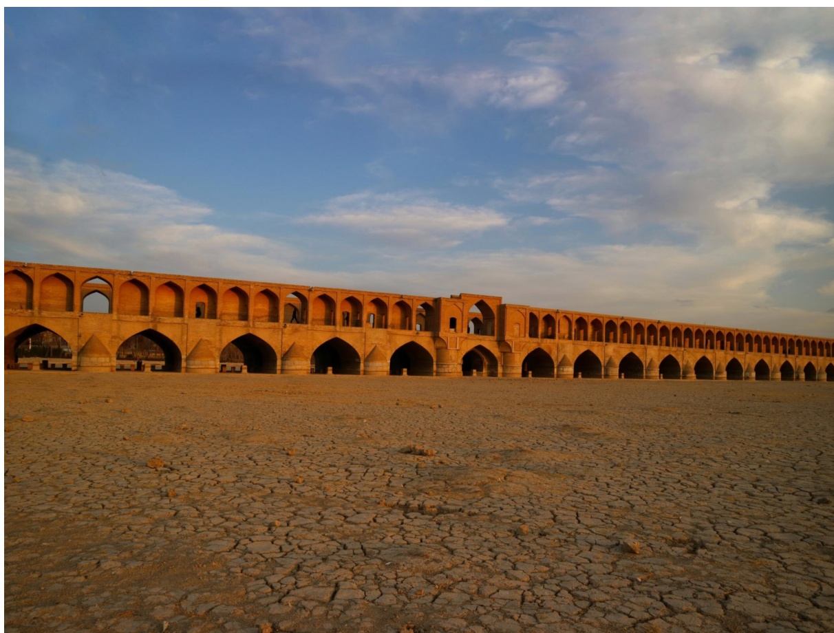
Il ponte di Allahverdi Khan sul fiume ormai secco, Isfahan (foto Wanchana Phuangwan).
